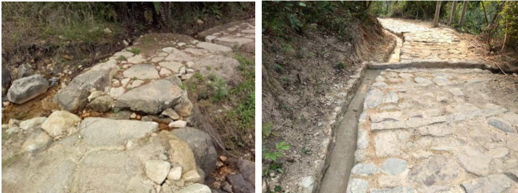
图 6.4.3-1（左图） 路堤型排水沟照片
