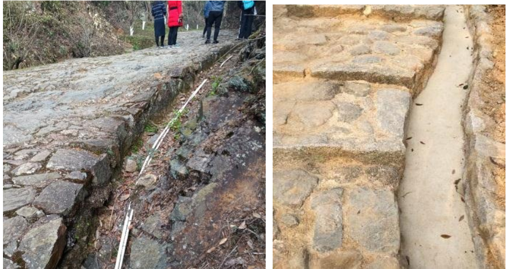
图 6.4.2-2 浆砌排水沟照片
