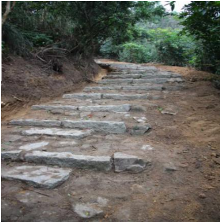
图 6.1-10 （左图） 长南径古驿道修复 照片
