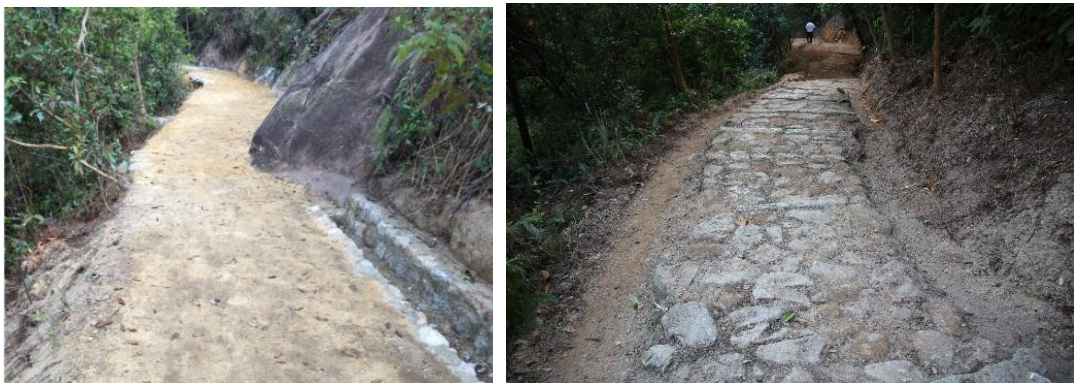
图 6.1-9 长南径古驿道 修复照片
