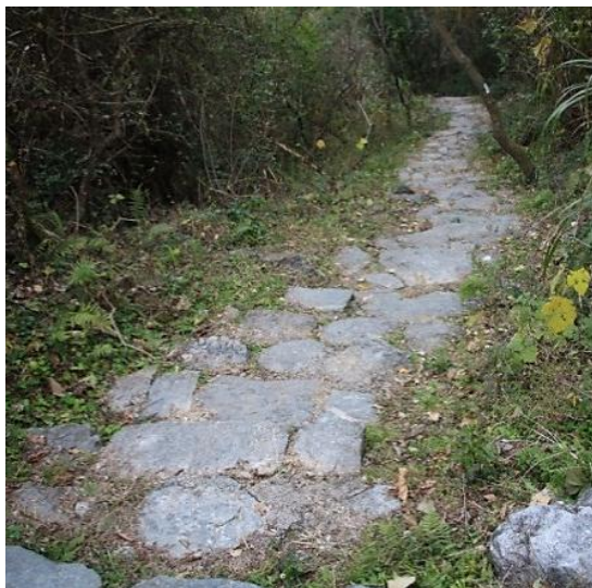
图 6.2.1-1 (左图) 西京古道现状照片
