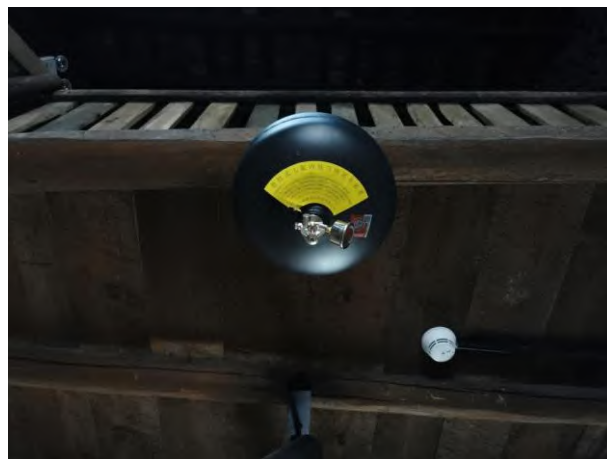
悬挂式七氟丙烷气体灭火装置
