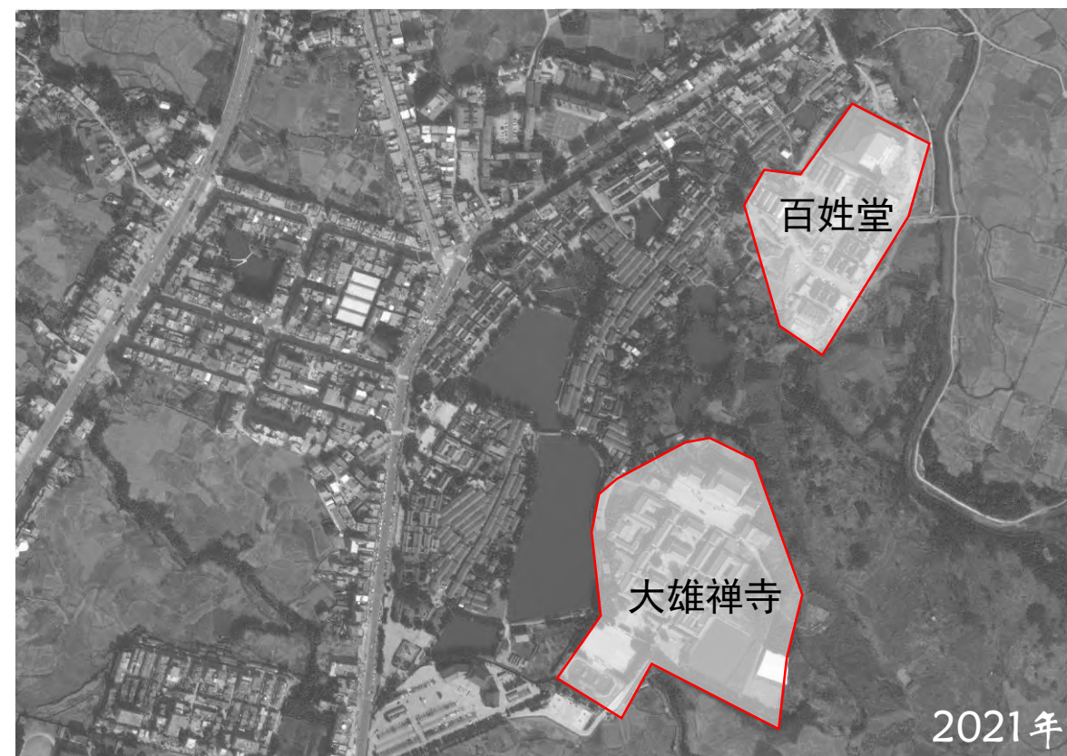
2016年5月，珠玑百姓堂开始建设，2021年基本完工
