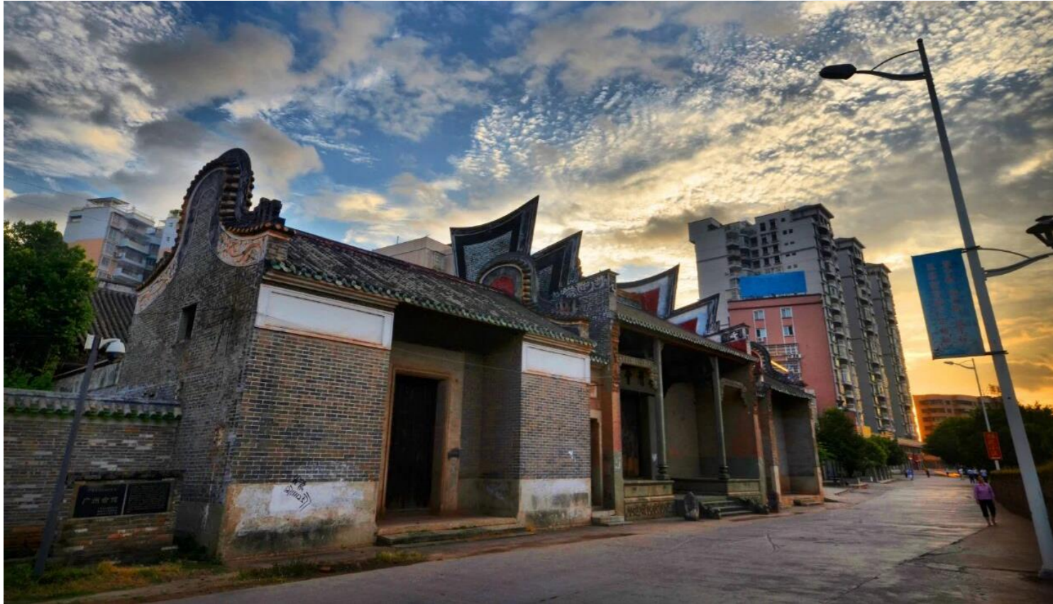
南雄青云路历史建筑：青砖黛瓦的传统风貌得以完整留存
