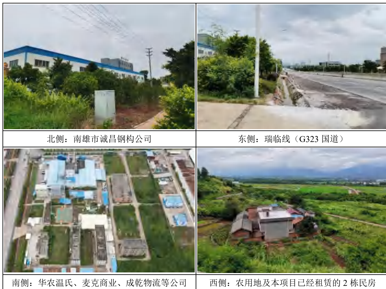
图 3.1.3 项目四至情况现场图
