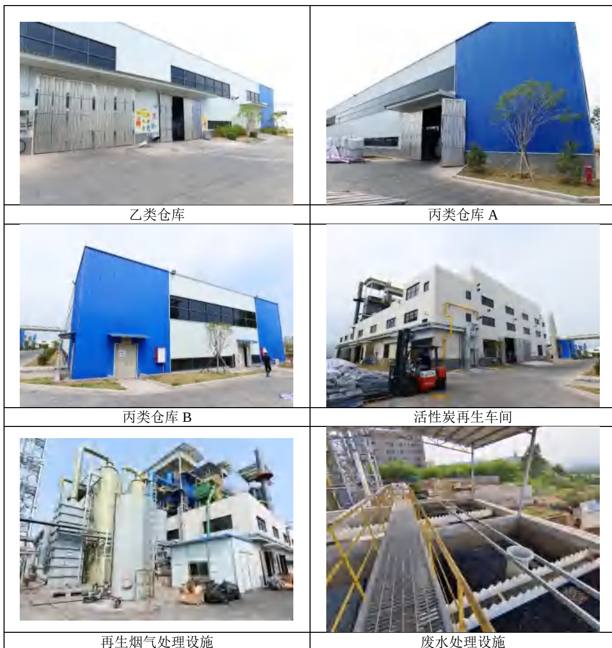
图 3.2-1 主体工程建设情况
