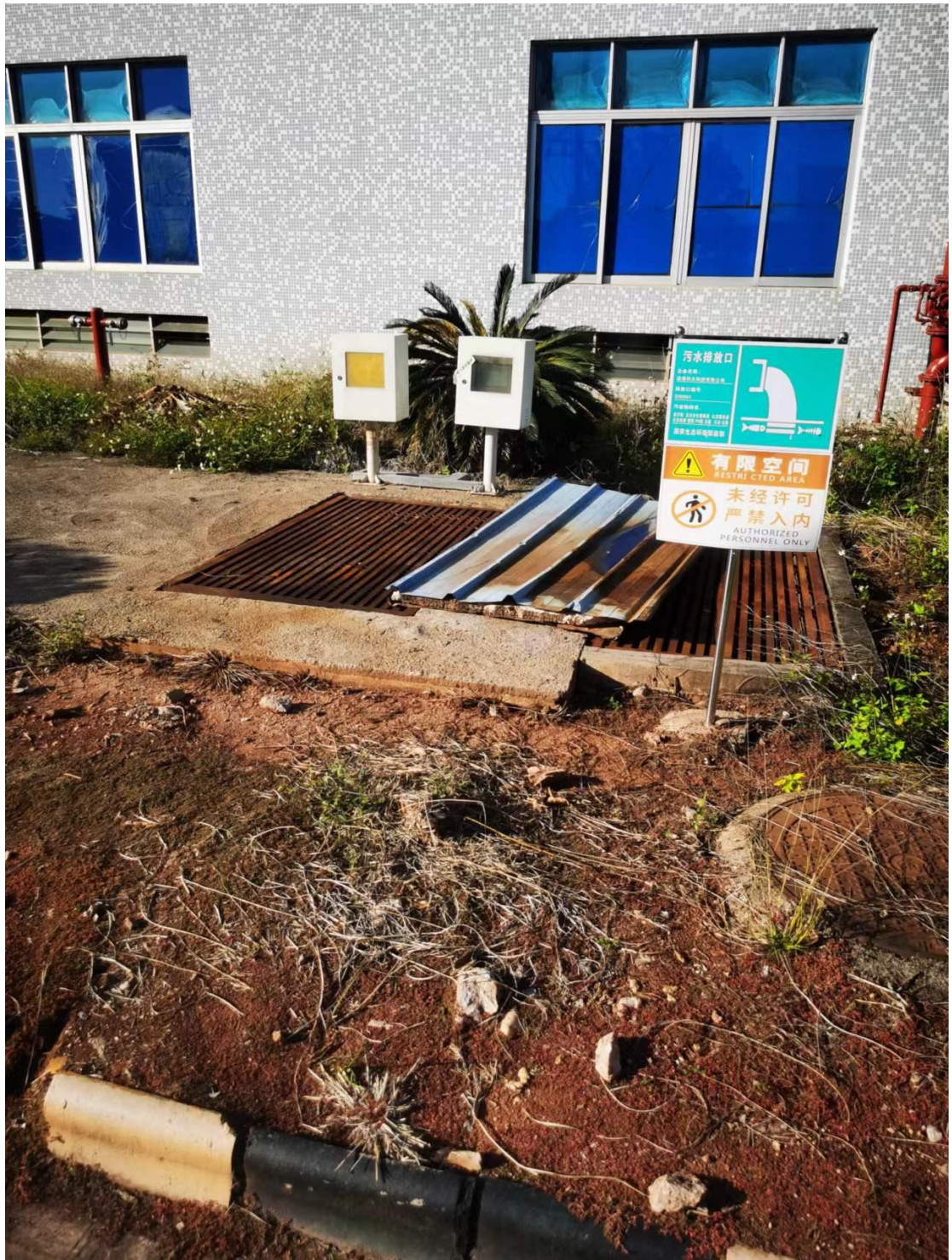
图4-1 厂区污水收集池
