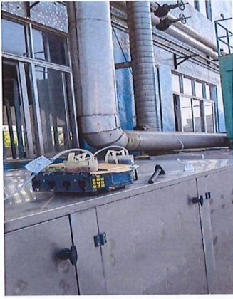
甲类车间 A 排气筒处理前
