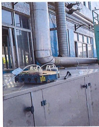
甲类车间 A 排气筒处理前
