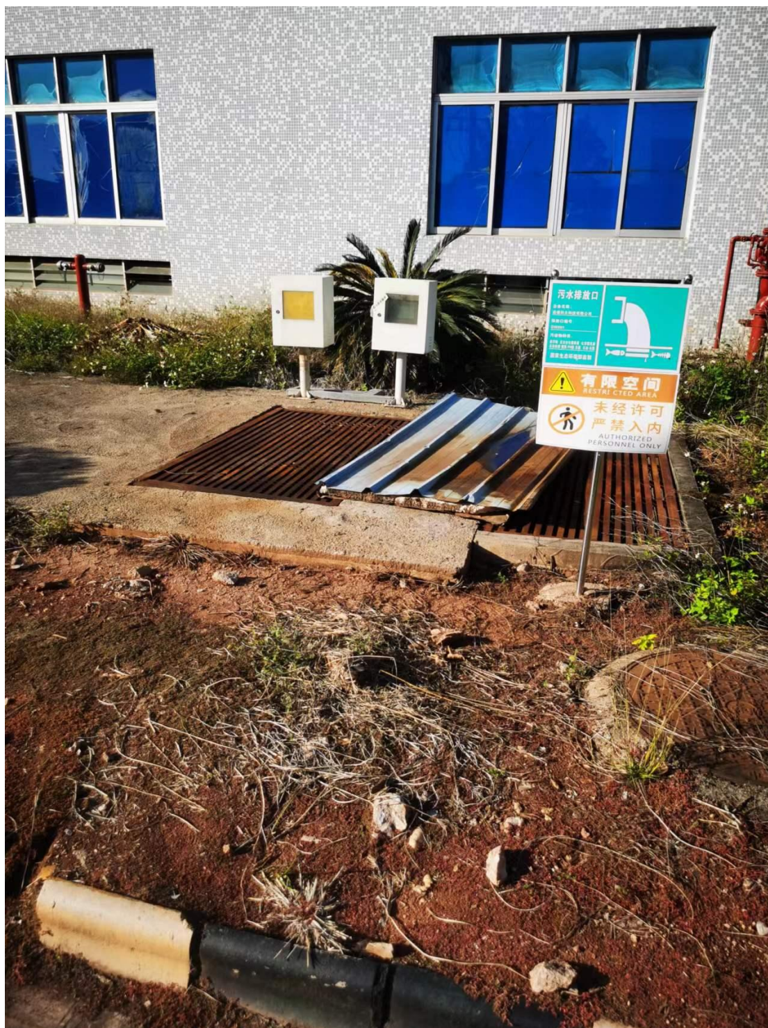
图4-1 厂区污水收集池
