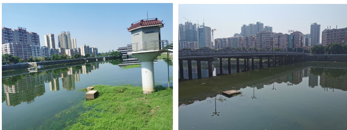
图 3-1 浈江城区段堤防
