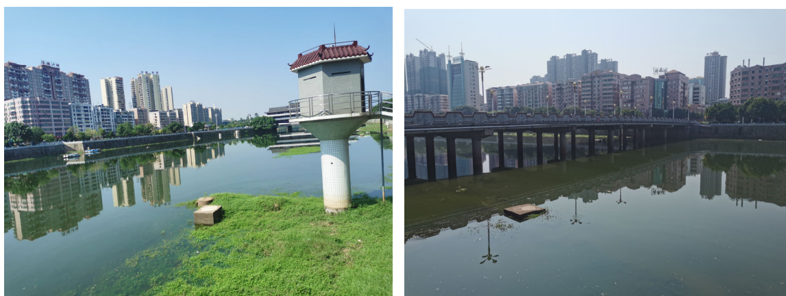
图 3-1 浈江城区段堤防
