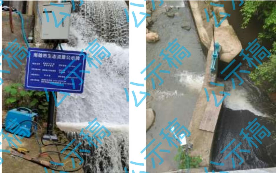
图 5-1 电站最小生态下泄流量现场照片
