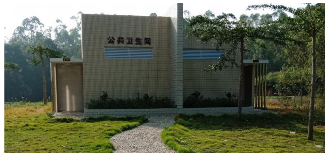
地点：汕尾市陆河县五星祠 建筑面积：66m 2 造价：约 19 万元 厕位：男（3 蹲位）女（4 蹲位）
