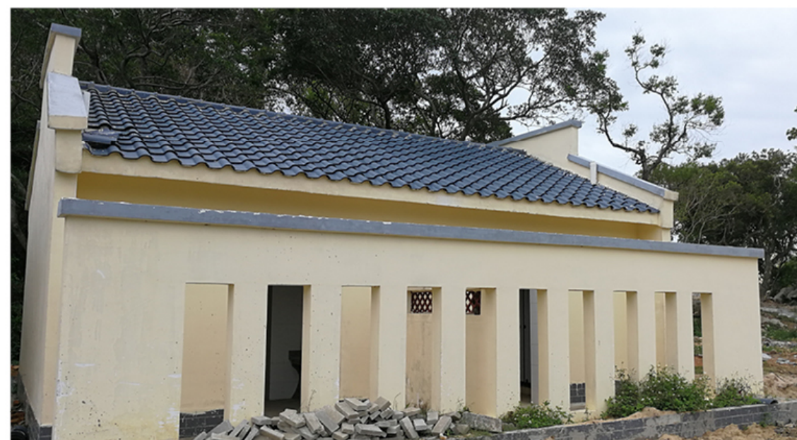
地点：阳江市东平镇杨屋村 建筑面积：51.6m 2 造价：约 16 万元 厕位：男（5 蹲位、3 站位，1 坐位）女（8 蹲位）
