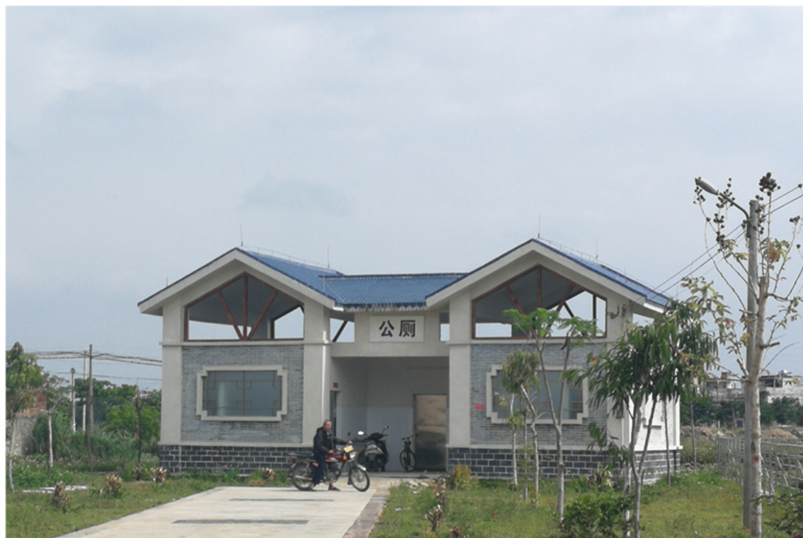
地点：阳江市东平镇良洞村
