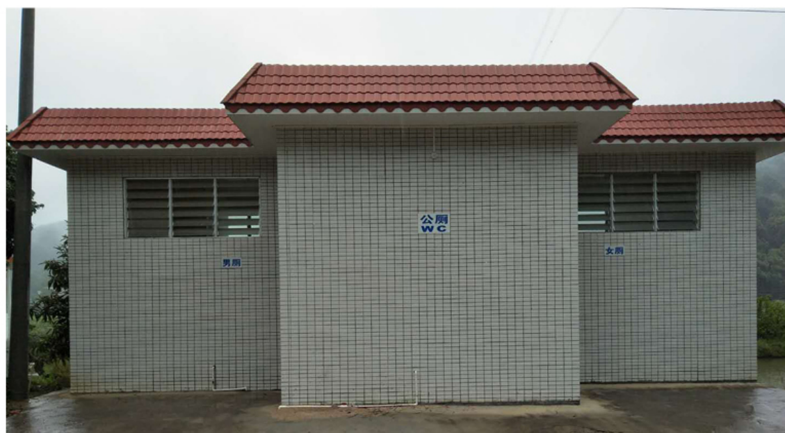
地点：云浮市平台镇 建筑面积：40m 2 造价：约 15 万元 厕位：男（2 蹲位、3 站位，1 坐位）女（2 蹲位、1 坐位）
